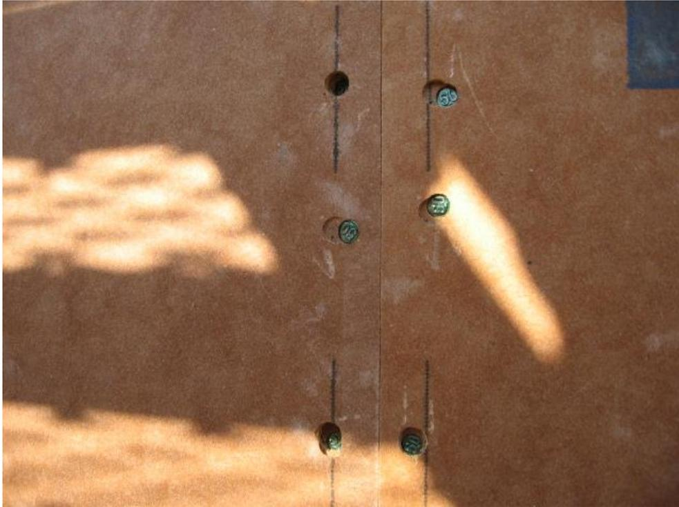
外壁の防水紙に配管を通した際に防水テープで配管の周りをキチンと施工しないとここから雨漏りが発生するおそれがあります。
